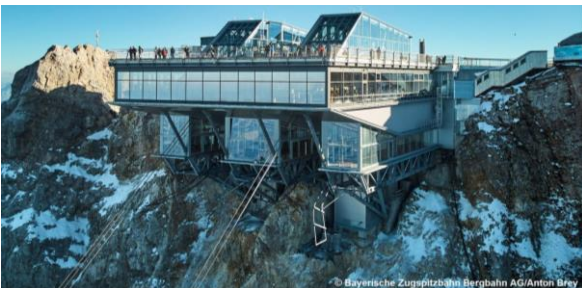
Bergstation Zugspitze Sie ist die neuste Bergstation.
